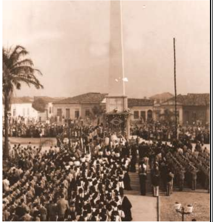
1958 Praça Frei Baraúna Antigo Fórum
