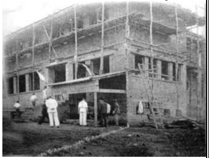
1939 Av Eugênio Salerno Construção da Escola Getúlio Vargas
